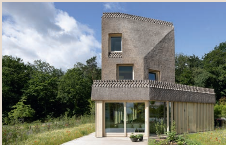
Huis Lichtenberg (9graden Architectuur, 2021) in Amersfoort is van HSB gebouwd en heeft bewust een kleine plattegrond. Het riet is traditioneel gevlochten
