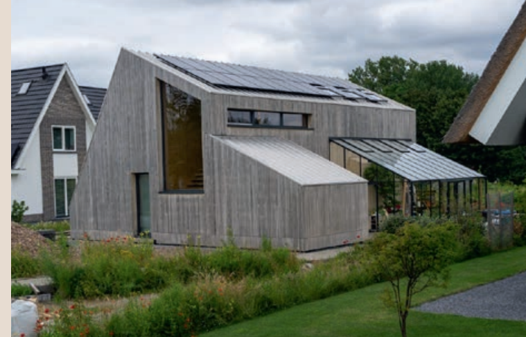
Dit huis in Delft, bijgenaamd 'De Schoen' (September Architectuur, 2021), bekleed met Accoya, is gebouwd van CLT.
