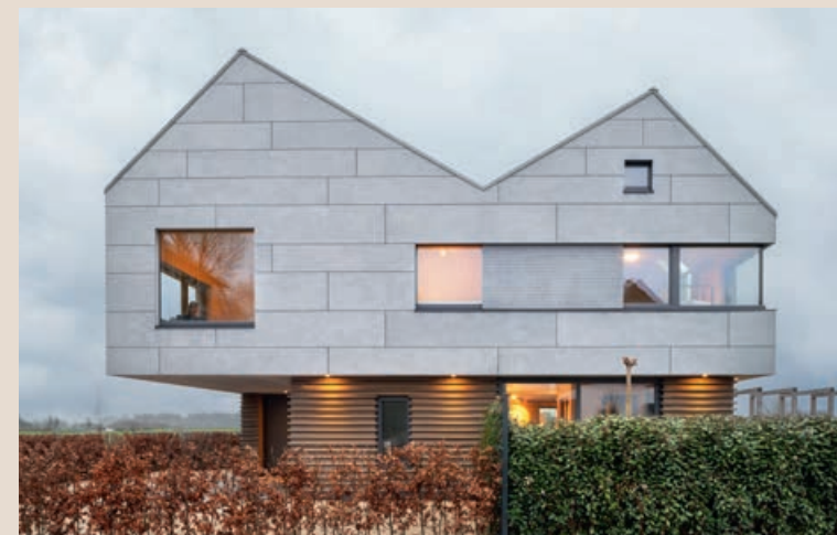
Dit woonhuis in Amstelveen (Marco van Zal Architects, 2023) maakt optimaal gebruik van de constructieve mogelijkheden van CLT.
